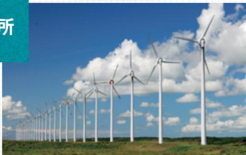
オトンルイ風力発電所【施設概要】 所在地:幌延町字浜里 ・基数:28基 ・総出力:21,000kW(750kW×28)
